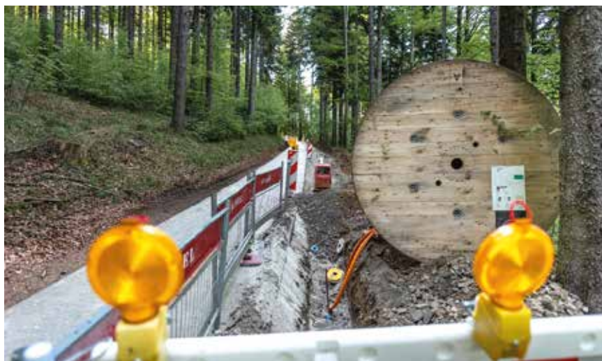
Als geplanter Baustart für den flächendeckenden Ausbau wurde von Seiten der A1 Telekom AG Frühjahr 2024 genannt.
