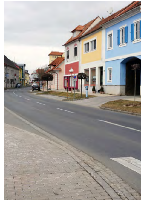
An der Ortsdurchfahrt B65 wird die Asphaltdecke von Höhe Rotkreuz-Dienststelle bis zur Kapelle Dörfel erneuert.
