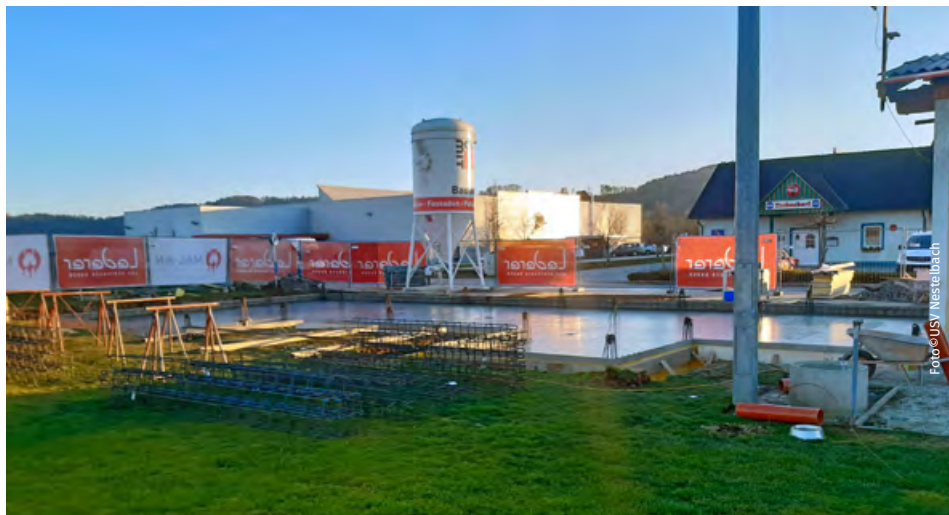
Die Arbeiten wurden bereits in Angriff genommen.
