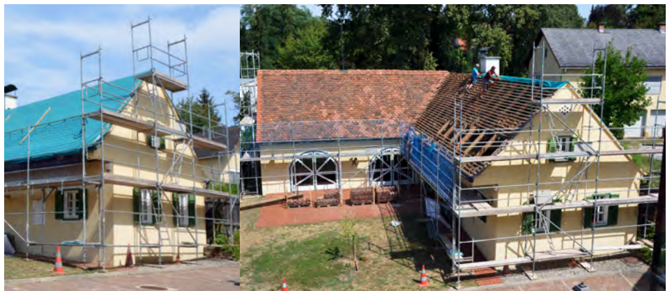
Seit Ende August wird am Dach des Heimatmuseums gearbeitet.
