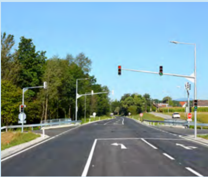
Die Ampelanlage an der B65 ist bereits in Betrieb.
