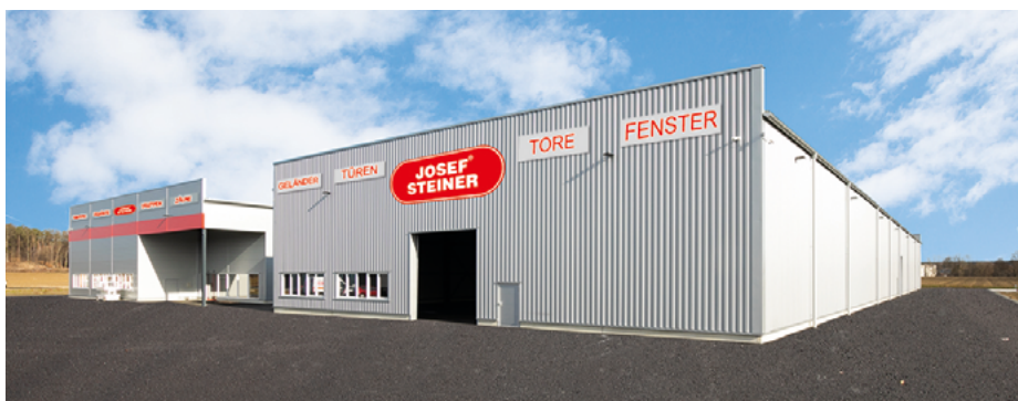
Moderner Filialstandort im Industriegebiet Neudorf. Foto ©H. u. J. Steiner GmbH
