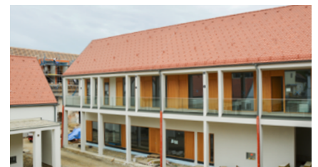
Das Bauprojekt ist weit fortgeschritten.
